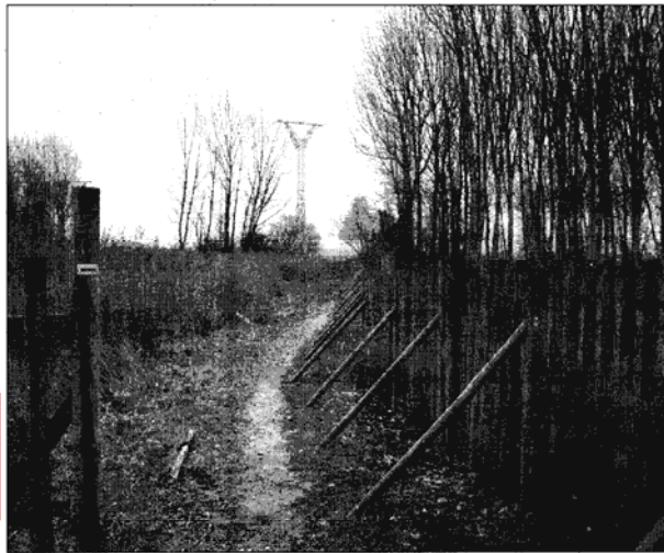
Empalizada para contener los sedimentos de las avenidas y no colmaten los Ojos de Monreal
